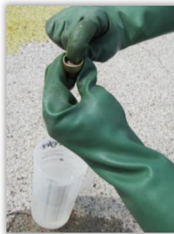
Rys. 125. Przepłukiwanie zaworu przeciwkroplowego.
