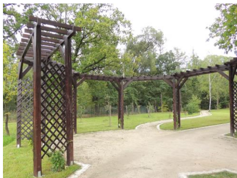
Konstrukcja pod pergolę
