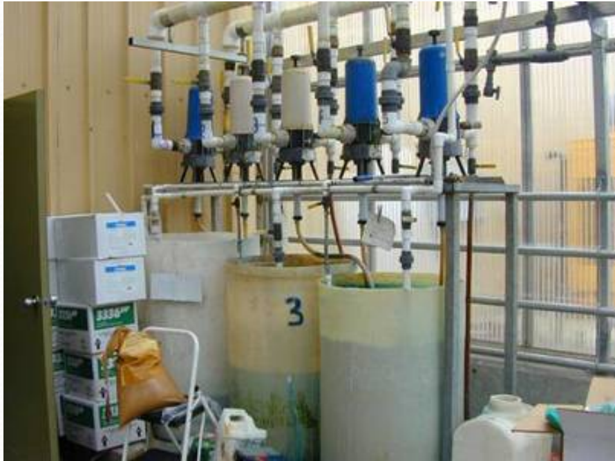
Fertygacja - injektory nawozów
