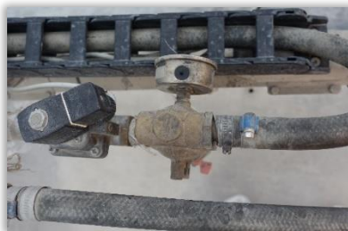
Rys. 44. Sprawdzanie jakości połączeń układu cieczowego.
