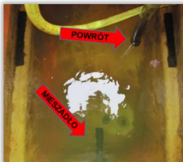
Rys. 24. Mieszadło hydrauliczne i przewód powrotny do zbiornika.
