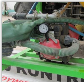
Rys. 32. Sprawdzenie ciśnienia w powietrzniku przy użyciu podręcznego manometru.
