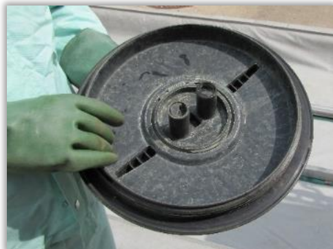
Rys. 21. Zawór napowietrzający pokrywę zbiornika.
