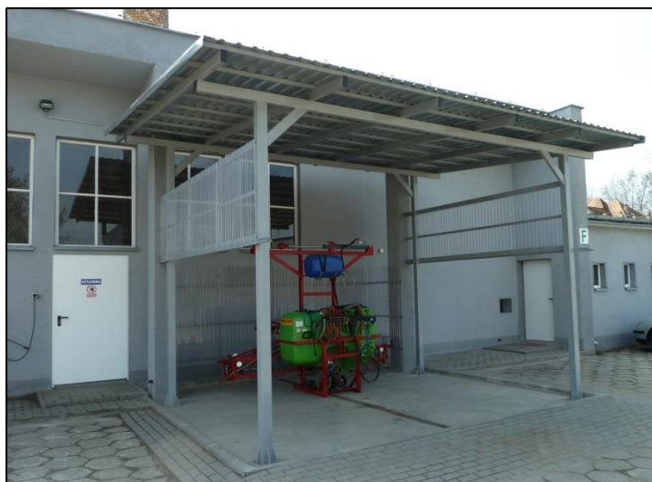
Rys. 24. Zadaszone stanowisko do mycia opryskiwaczy
