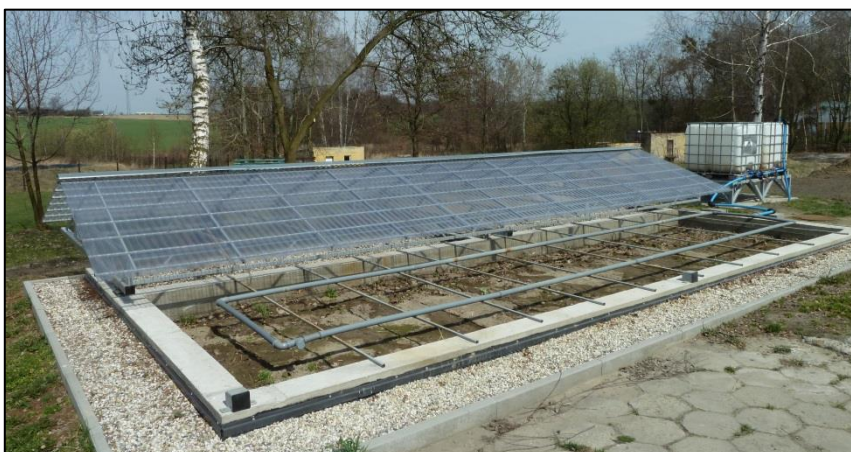
Rys. 42. Zagłębione stanowisko PHYTOBAC z odsuwającym dachem
