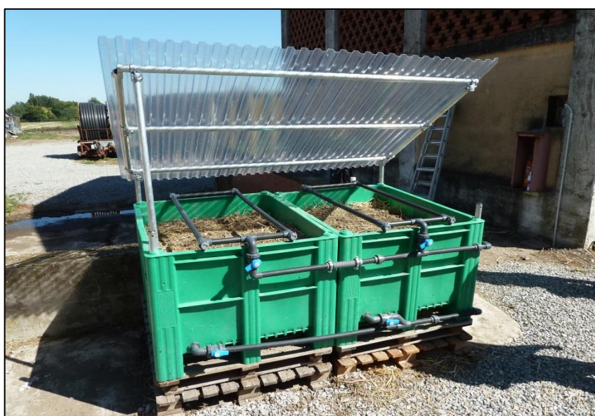
Rys. 43. Wolnostojące stanowisko PHYTOBAC w wersji kompaktowej.
