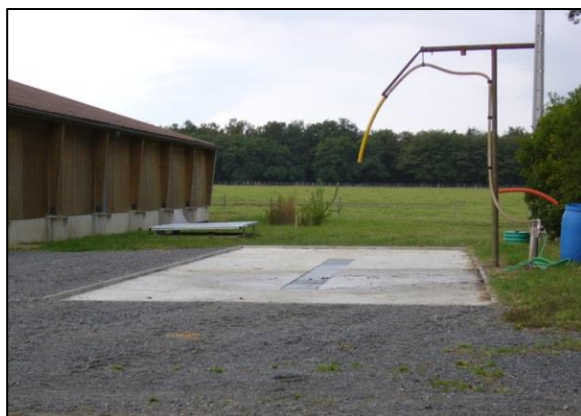
Rys. 10. Stanowisko do napełniania i mycia opryskiwaczy na płycie betonowej
