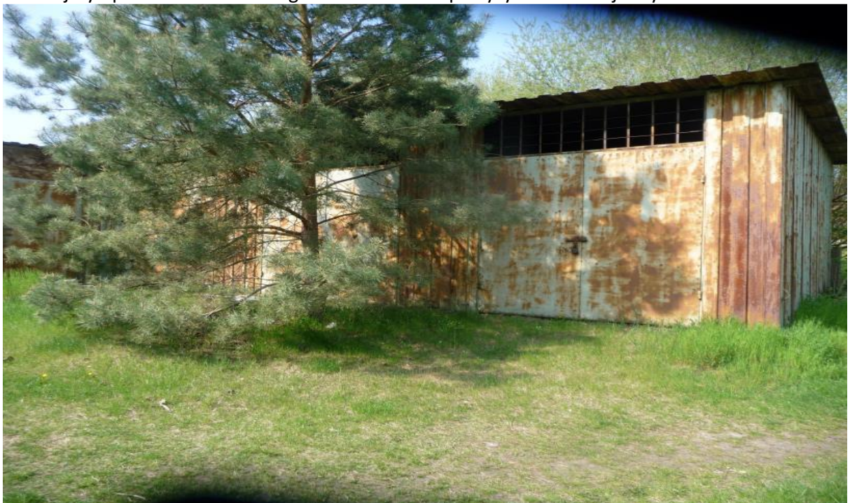
Widok ogólny budynku nr 7
