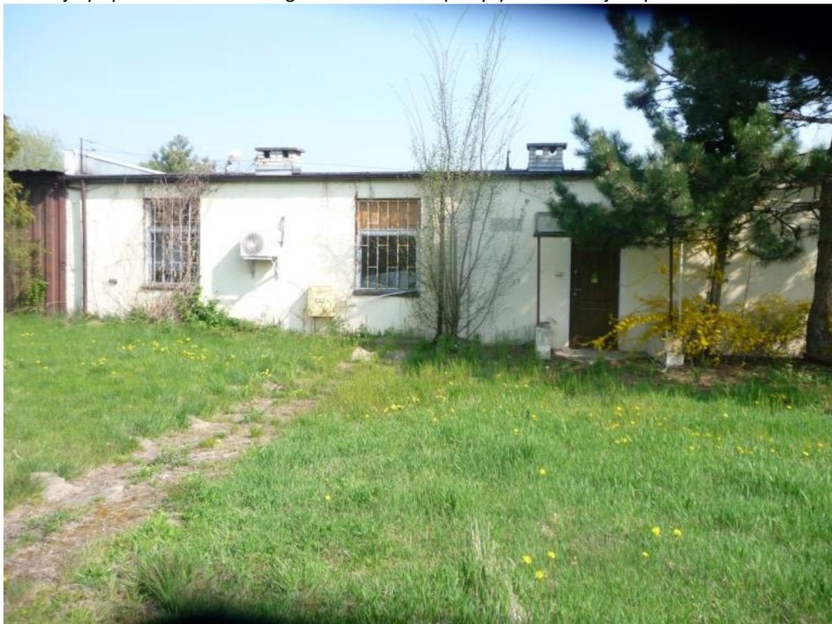
Widok ogólny budynku nr 5
