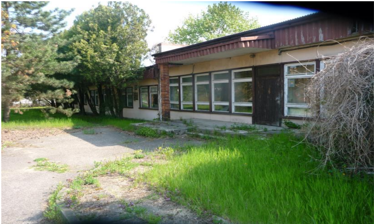
Widok ogólny budynku nr 6
