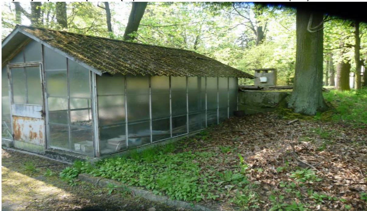
Widok ogólny obiektu (piwnicy)
