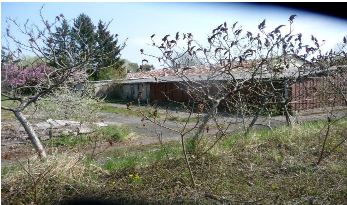
Widok ogólny budynku nr 9
