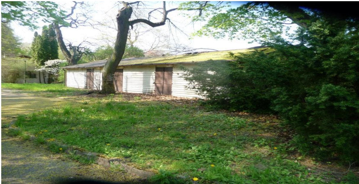
Widok ogólny budynku nr 12
