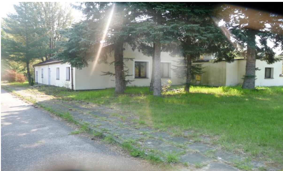
Widok ogólny budynku nr 3
