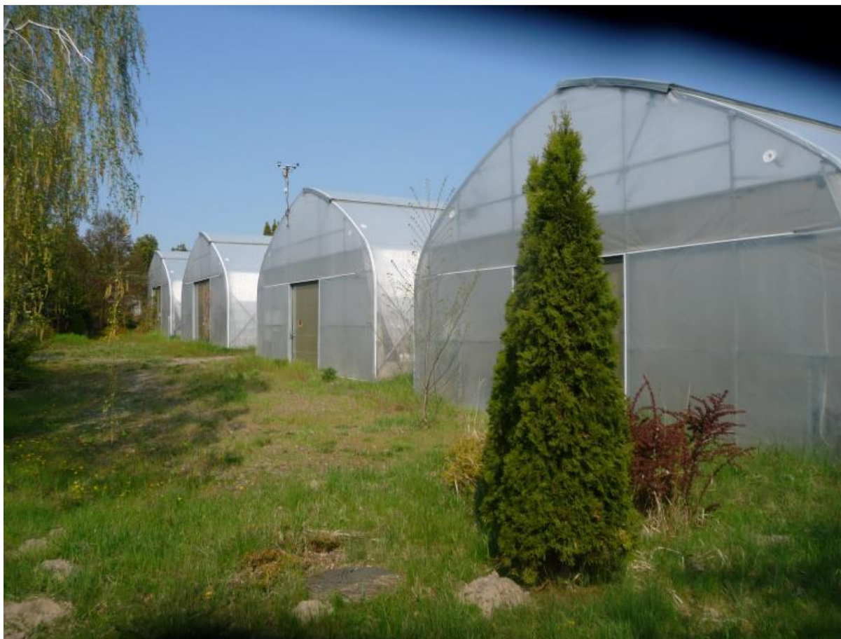
Widok ogólny budowli
