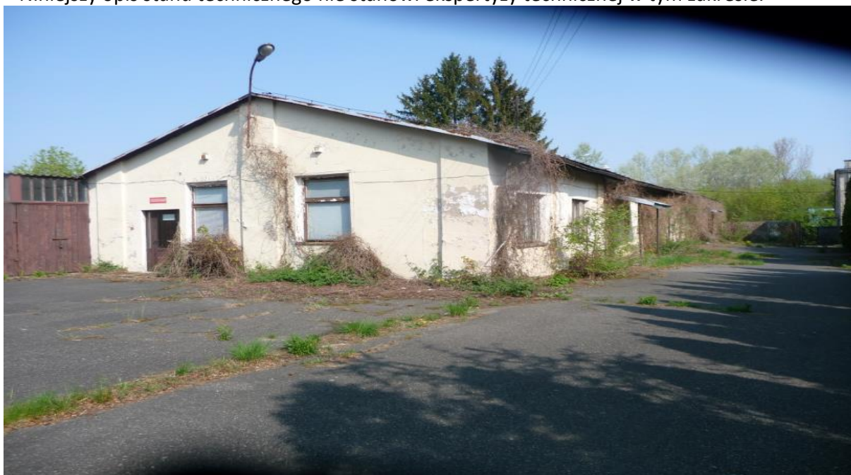
Widok ogólny budynku nr 4
