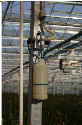
Fot. 43. Zbiornik na stężoną ciecz do aerozolowania
