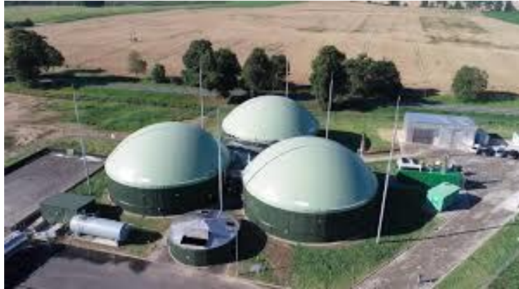
Rys. 5 Zdjęcie Biogazowni rolniczej
