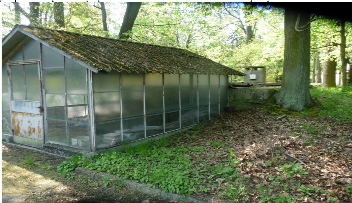
Widok ogólny obiektu (piwnicy)
