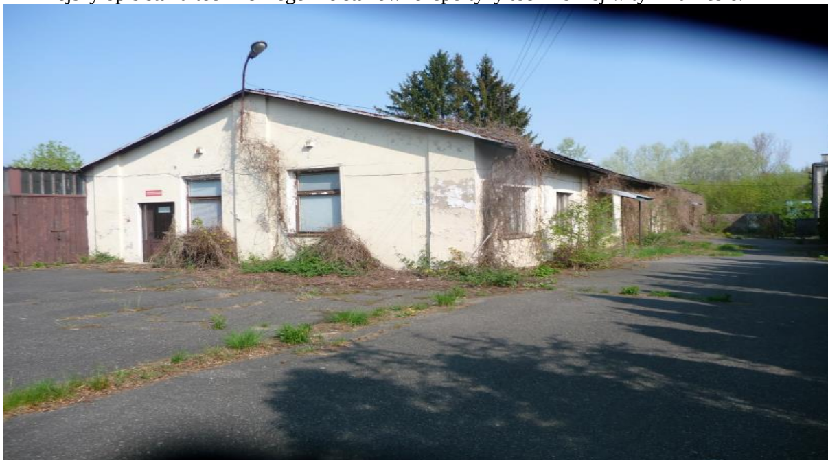
Widok ogólny budynku nr 4
