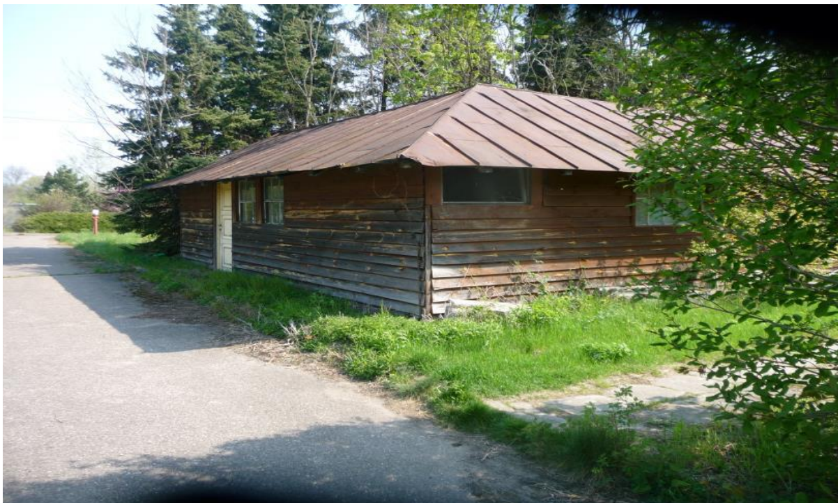
Widok ogólny budynku nr 9
