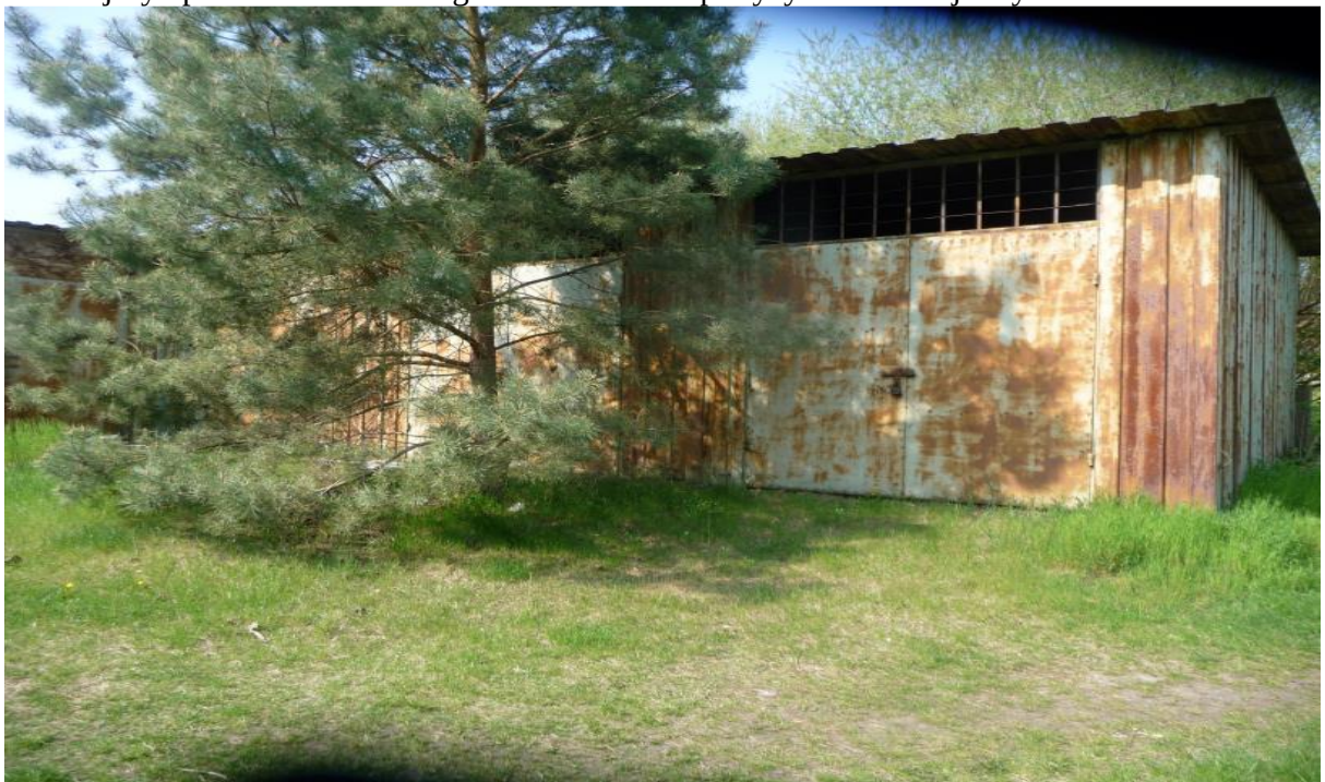
Widok ogólny budynku nr 7
