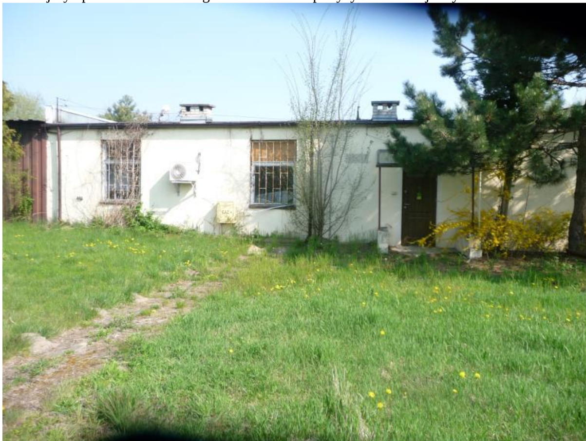
Widok ogólny budynku nr 5
