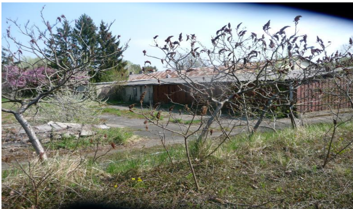
Widok ogólny budynku nr 8
