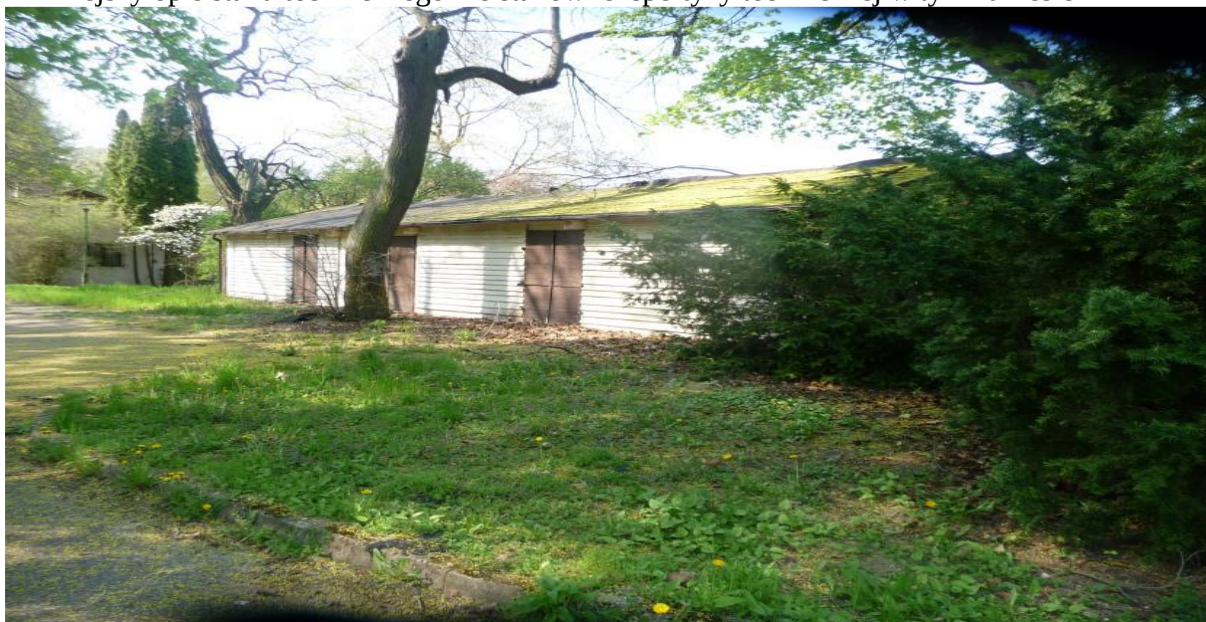
Widok ogólny budynku nr 11
